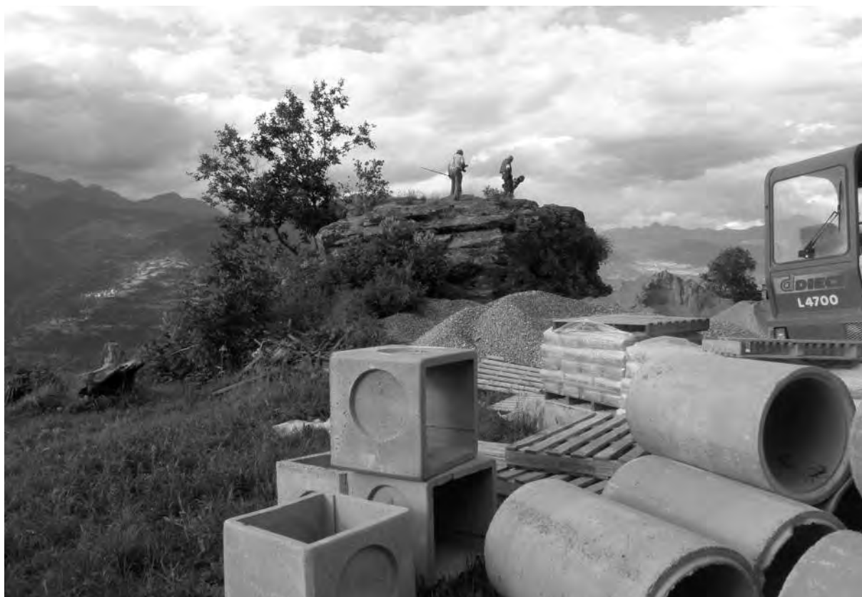
Fig. 22 - Saint-Marcel, la roche à cupules de Seissogne menacée par des travaux.
