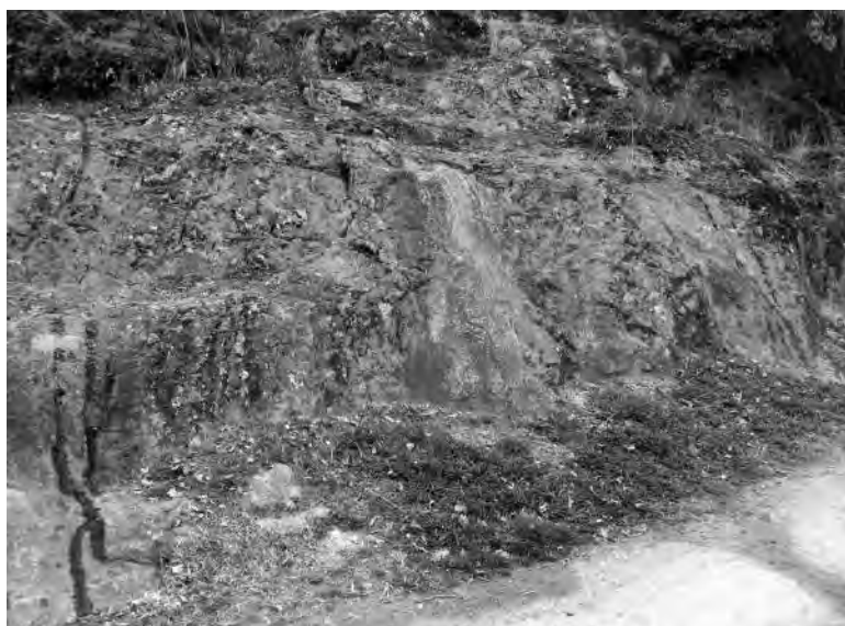
Fig. 4 - canaletti e scivolo (foto di F. Morello).
