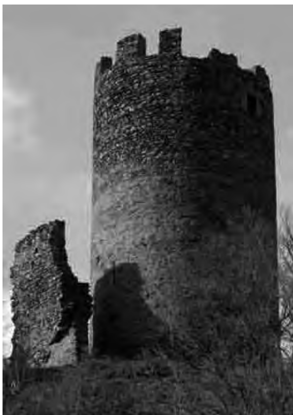
Fig. 12 - Torre cilindrica del castello di Brissogne, 2009.
