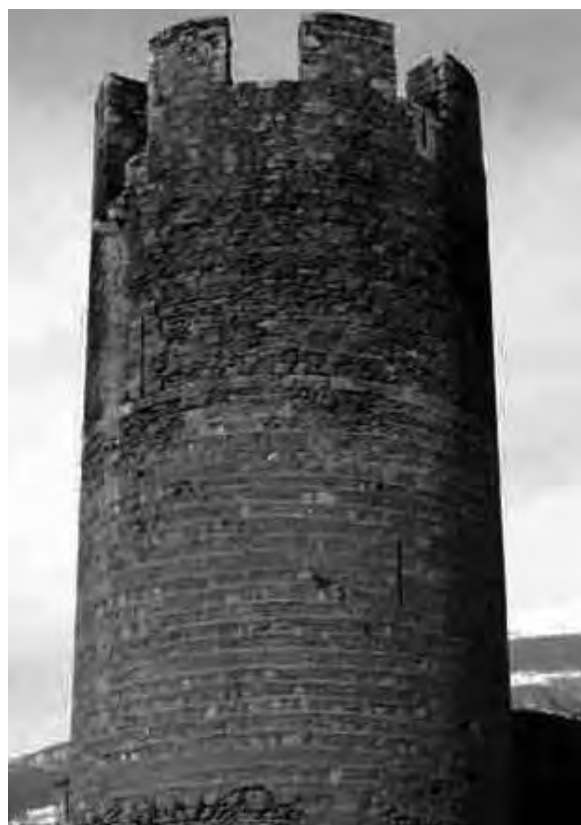
Fig. 13 - Torre cilindrica del castello di Bramafam, 2009.
