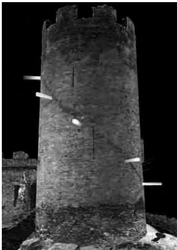
Fig. 15 - Châtel-Argent, Scansione laser con posizionamento dei travicelli dell’impalcato (L. Bornaz – SIR srl Aosta).
