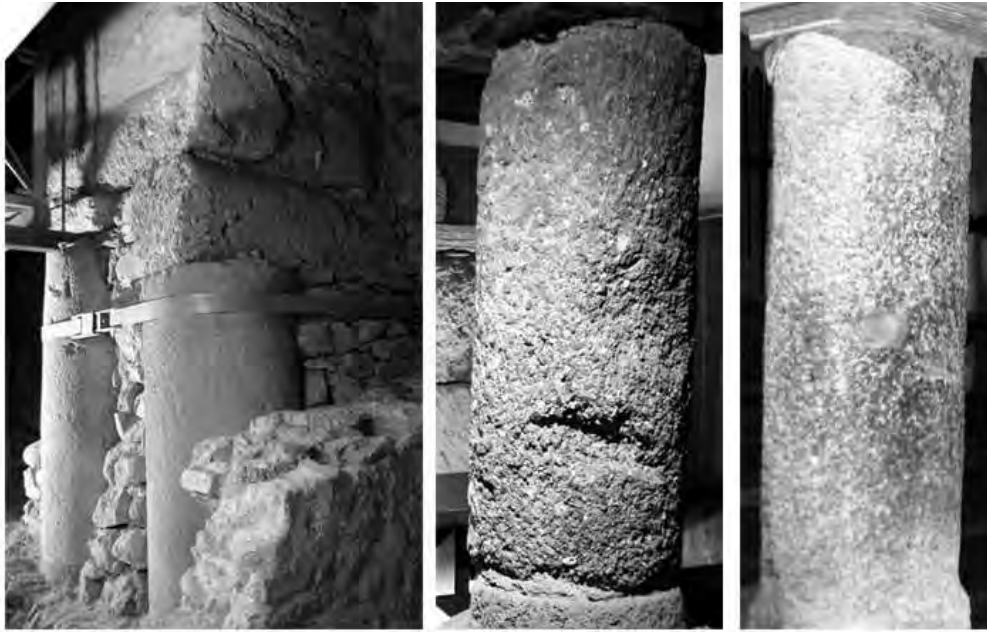
Fig. 22 - Tamburi in conglomerato reimpiegati: a sinistra fondazione del massiccio occidentale della Cattedrale.
