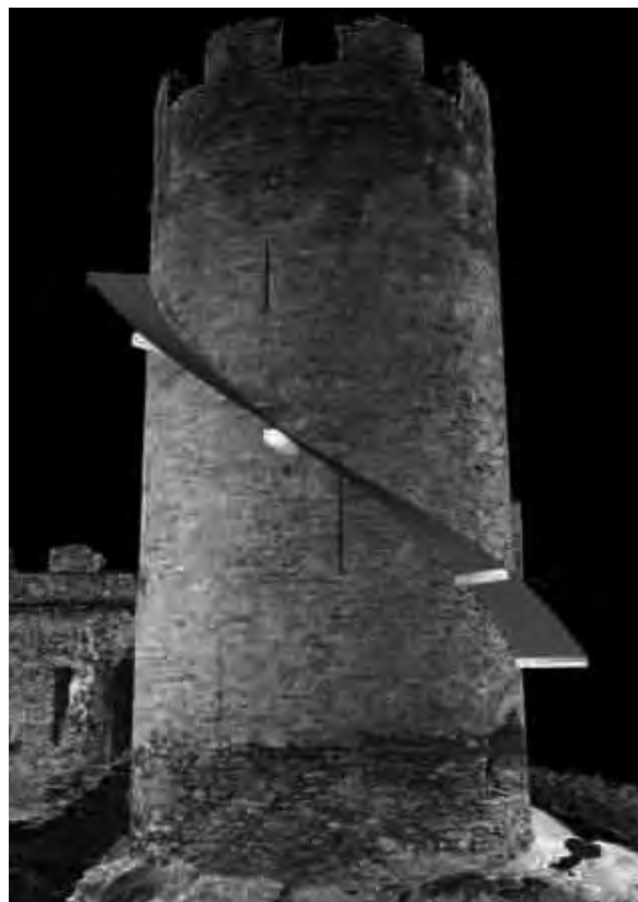
Fig. 16 - Châtel-Argent, Scansione laser con inserimento della rampa elicoidale sui travicelli (L. Bornaz – SIR srl Aosta).
