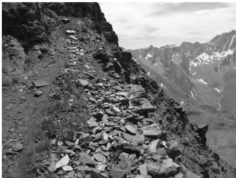
Fig. 3 - Versant ouest de l'Arête des Bastillons (2754 m). Restes d'un mur de soutènement en partie effondré dans la paroi rocheuse.
