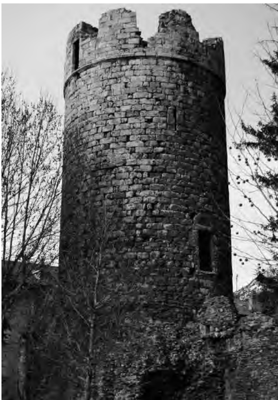
Fig. 16 - La Tourneuve (Aosta) posizionata sull'angolo di nord ovest della cinta muraria di età romana, edificata tra il 1283 e il 1284.
