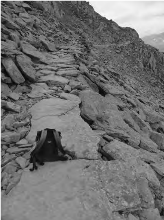
Fig. 9 - Versant sud du Col des Chevaux. Grandes dalles massives utilisées pour aménager le chemin.
