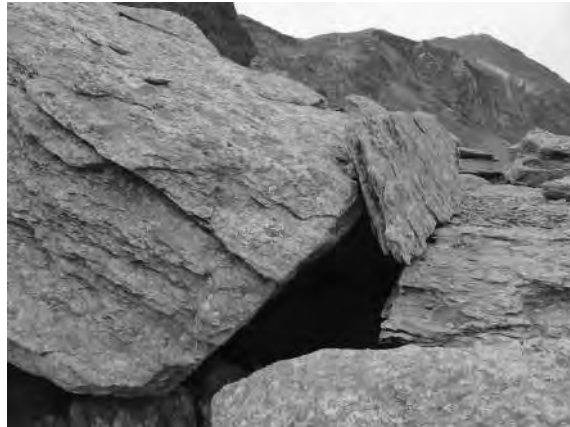
Fig. 10 - Versant sud du Col des Chevaux. Grandes dalles massives posées bout à bout pour franchir un éboulis de gros blocs.
