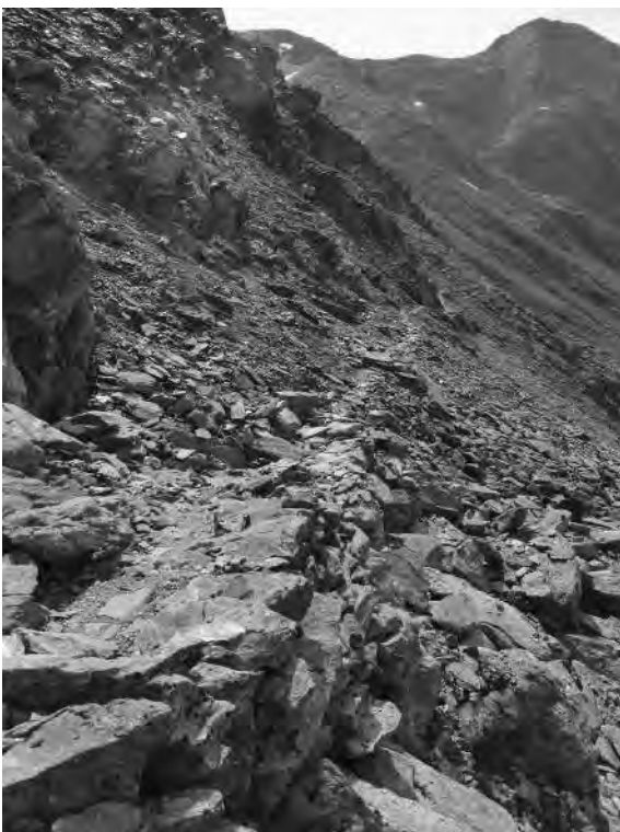
Fig. 11 - Le tracé encore plus ou moins discernable du Chemin des Sarrasins dans les pentes de la Pointe de Drônaz.
