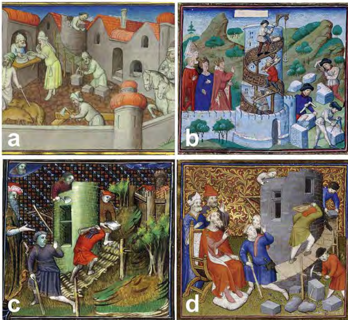
Fig. 10 - Iconografia dell'impalcato elicoidale (da M. Cortelazzo, Dinamiche di cantiere, tecniche costruttive e possesso territoriale nell'edificazione delle torri valdostane tra XI e XIII secolo , in Archeologia dell'Architettura , XVII, Firenze 2014, pp. 9-31, fig. 15).
