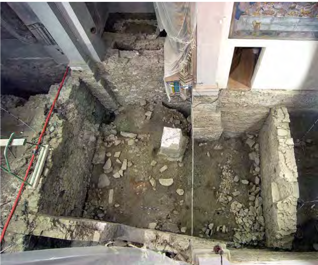
Fig. 18 - Saint-Léger di Aymavilles, l'edificio quadrangolare con pilastro centrale a ovest della cripta (S.E. Zanelli)
