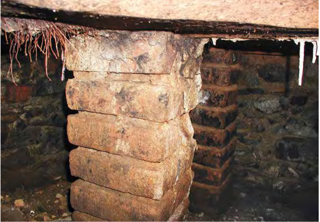
Fig. 11-12 - Sito fusorio di Ételey - L'interno dell'ipocausto con le suspensurae in laterizi quadrati impilati e il piano di copertura in mattoni modulari di grandi dimensioni (foto Castello P.).
