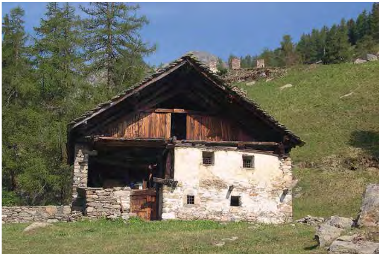
Issime, Gradunérp. Une habitation en bois de 1564, surélevée au début du XVII e siècle et masquée par des murs en maçonnerie enduite après un prix-fait rédigé le 7 mai 1764 à Quinçod de Challand-Saint-Anselme entre le soldat au régiment d'Aoste Jean-Antoine Goÿet et trois maçons d'Issime.
