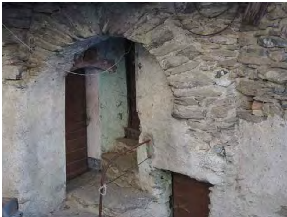
3. Saint-Denis, Orsières. Les constructions dans l'indivision sont grevées de servitudes de passage par suite du partage des espaces.
