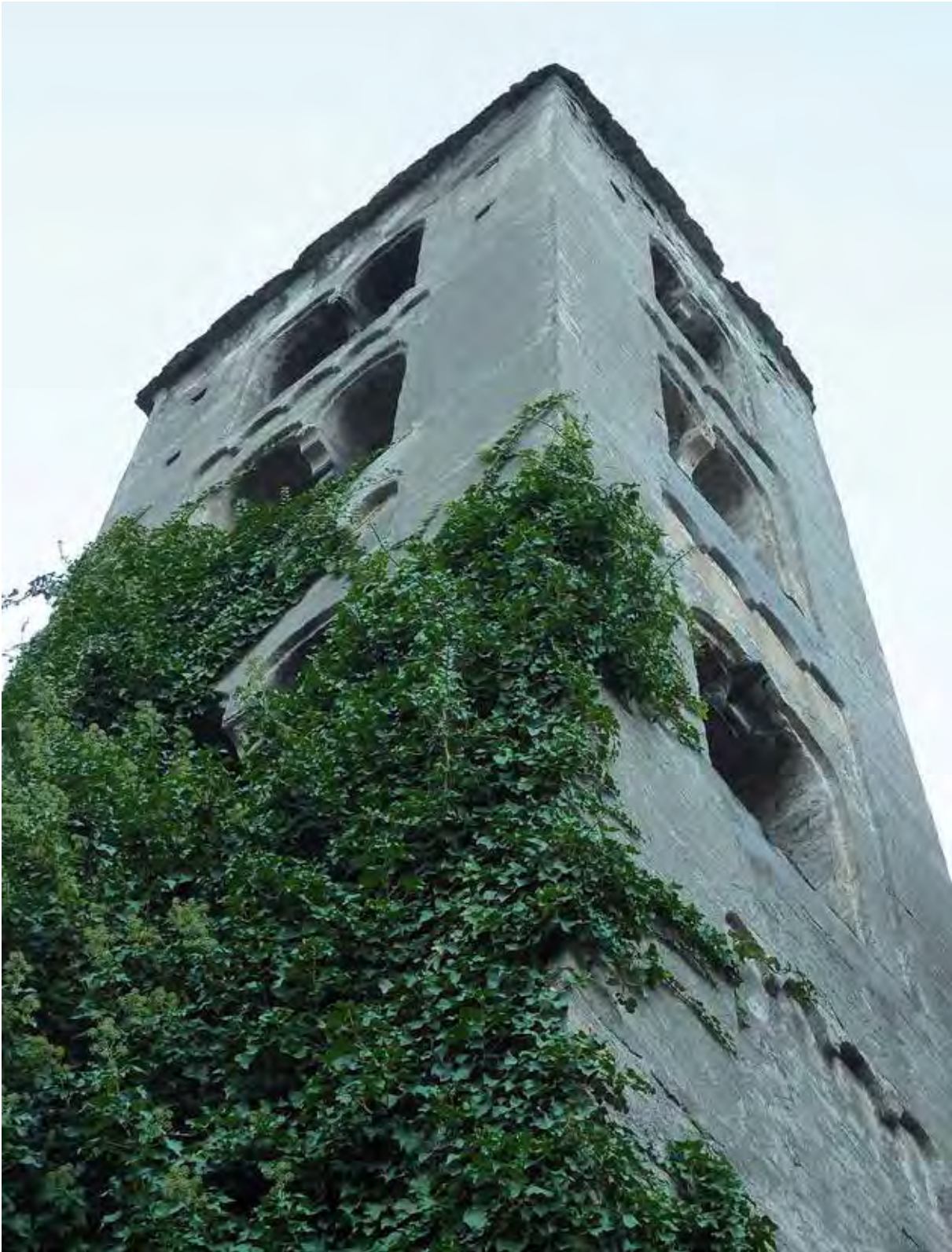
Fig. 21 - Chiesa di Saint-Bénin. Campanile.
