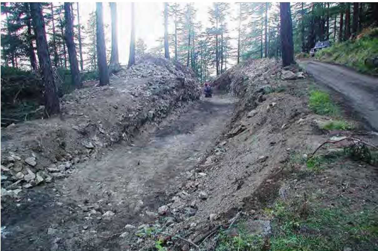
Fig. 3 - Sito fusorio di Ételey - Lo scavo realizzato per la posa della condotta (foto Castello P.).
