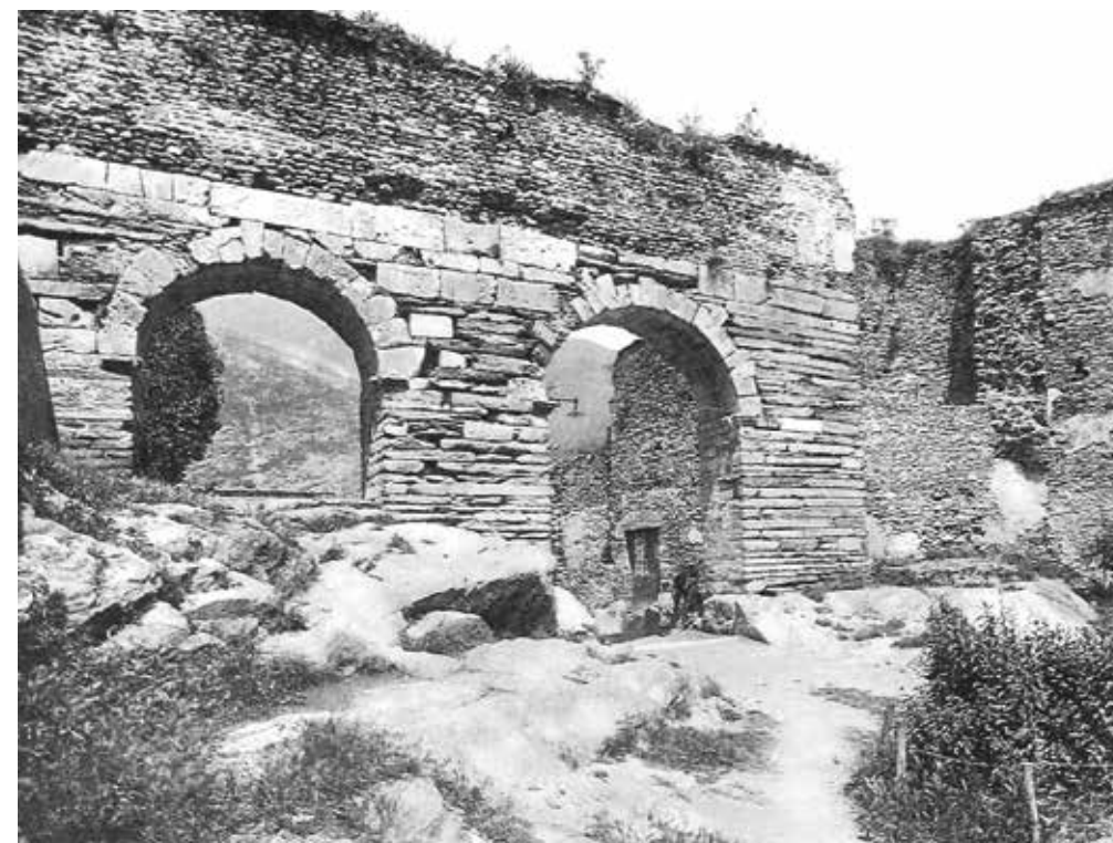
Fig. 5 – Foto dell'acquedotto Graziano scattata da sud dopo la ripulitura e l'abbassamento del sedimento stradale attorno al 1889 (da MERCANDO L., 1993, p. 204).
