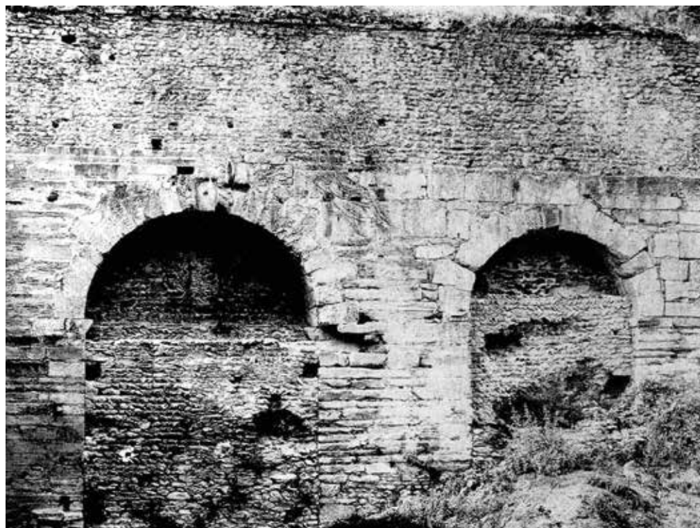
Fig. 3 – Prospetto verso nord degli archi dell'acquedotto di Graziano prima della eliminazione della tamponatura approvata nel 1883 dal Consiglio comunale e portata a termine nel 1884.
